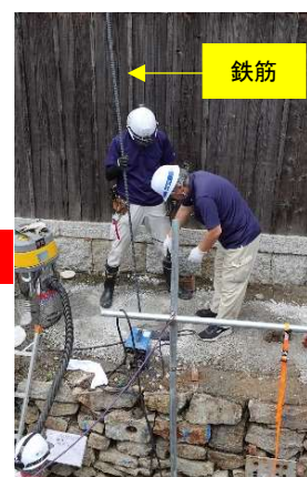
写真3 鉄筋挿入
