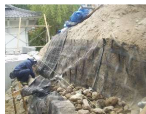
写真-5 巻込み式ジオグリッドの施工状況
