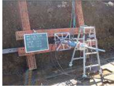
写2 引抜実験状況
