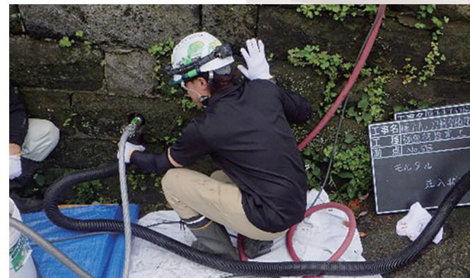
グラウト注入
