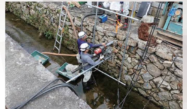
バットレスアンカー施工
