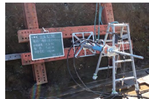
引抜実験状況
