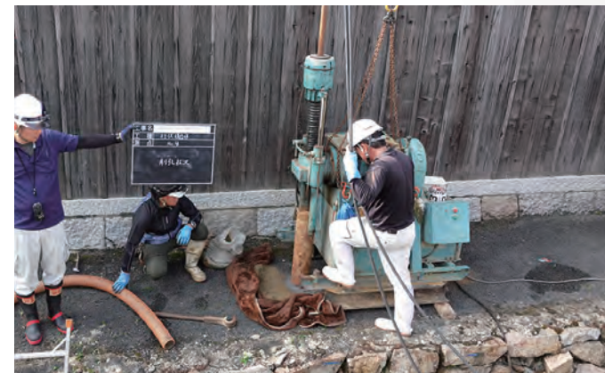
柱状構造体施工
