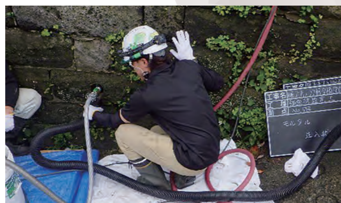
グラウト注入
