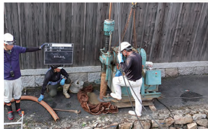
柱状構造体施工
