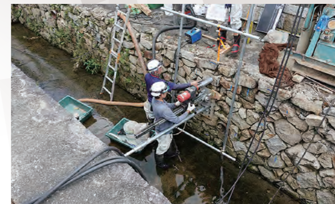
バットレスアンカー施工
